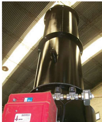
Ilustración 10:chimenea del Horno Crematorio
