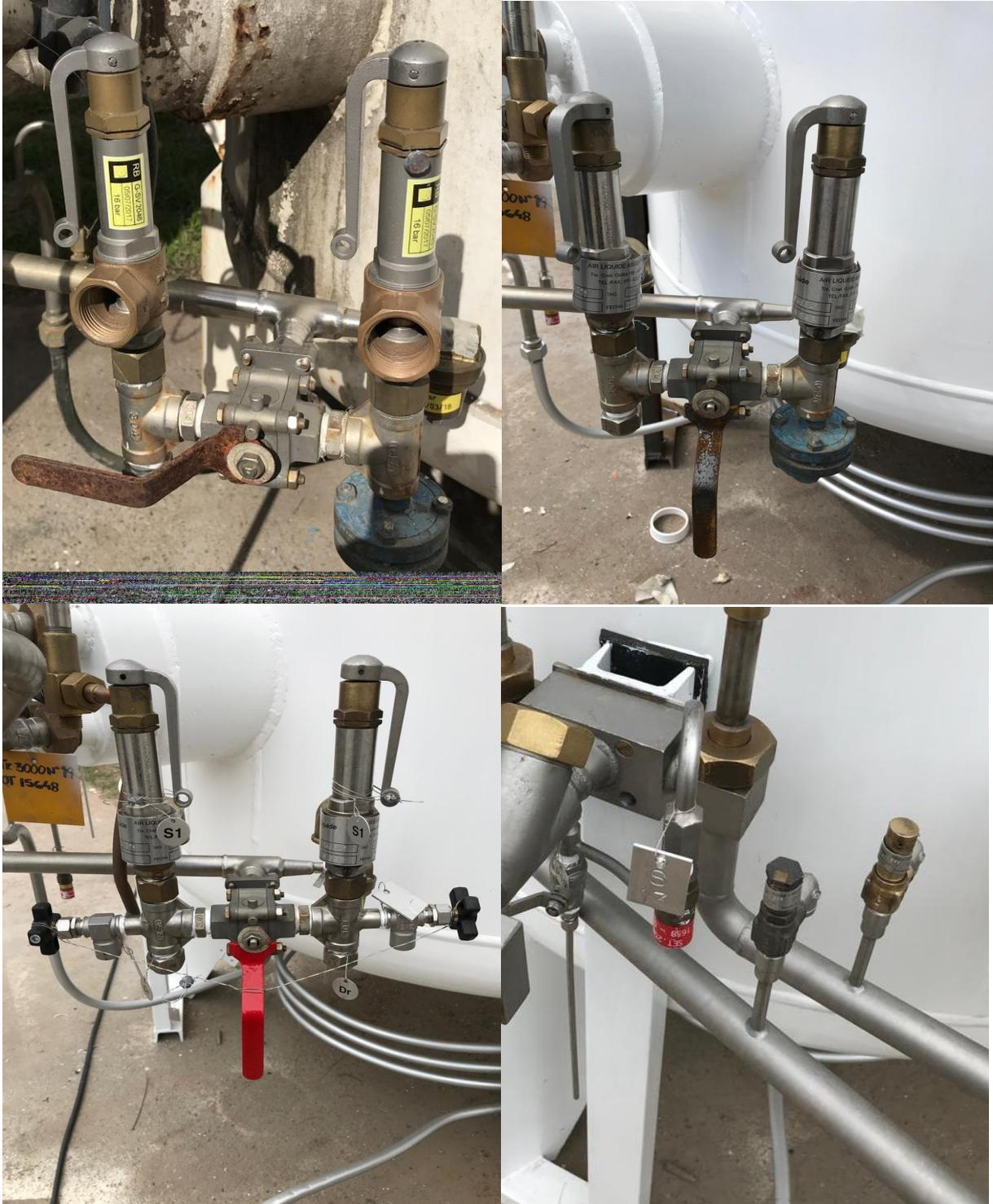
b. Control del sentido del regulador de presión desde el lado líquido hacia el gas, y del regulador economizador hacia consumo (Rp y Re.)
