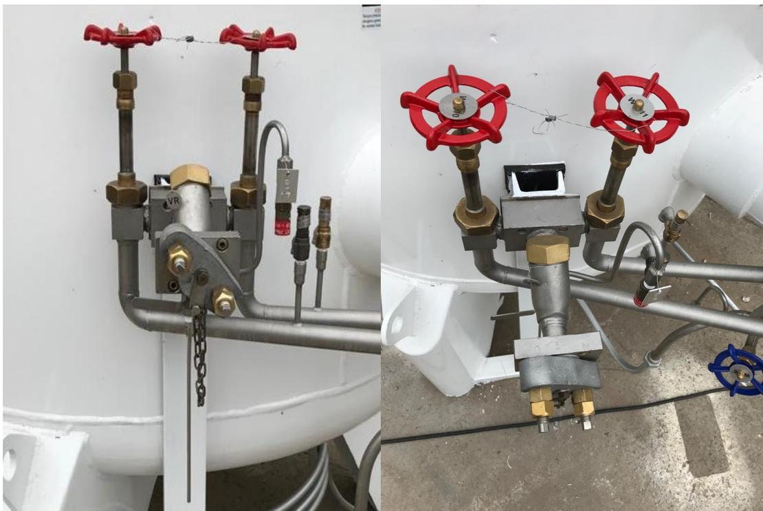
Las válvulas criogénicas V1 y V2 permiten controlar el ingreso de producto al tanque. El diseño de las válvulas criogénicas es de vástago extendido con el fin de reducir la transferencia de calor. La mayoría de componentes de la válvula criogénica se construyen en acero inoxidable, en las siguientes figuras se indican los componentes de la válvula criogénica.
