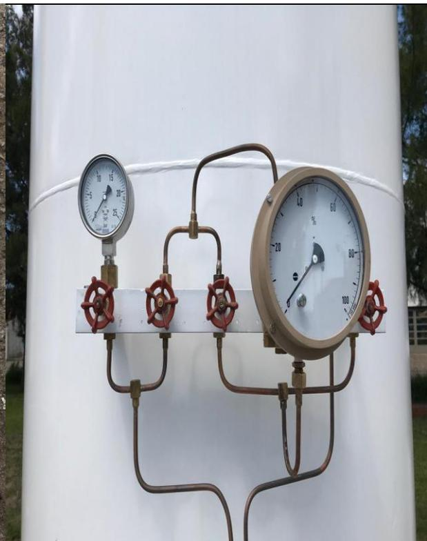
El manómetro del tanque nº19 fue comparado con otro manómetro (llamémoslo "B") para verificar que la medición del manómetro nº19 no sufrió alteraciones y que su valor sea el correcto. A su vez, el manómetro "B", fue constatado antes con el manómetro PATRON (llamamos lo "A").
