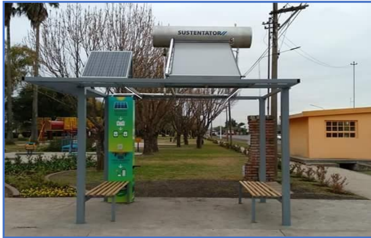
Imagen1: Parada en la provincia de santa fe, posee cargador de celular y agua caliente
