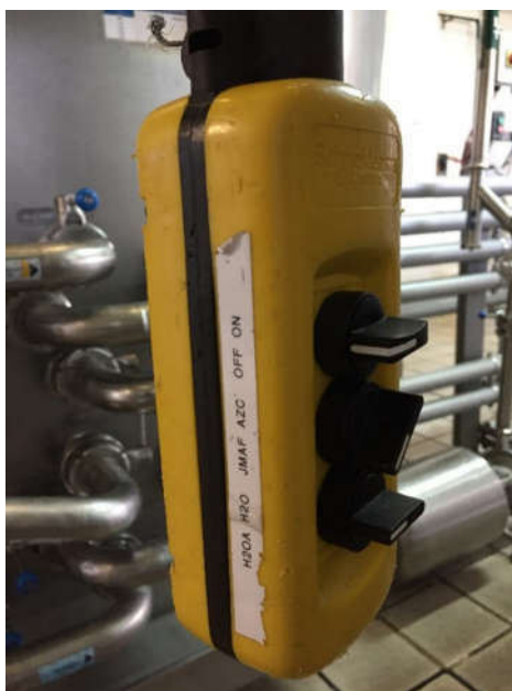
Imagen 1: Pulsadores de control de envío de Agua Tratada a tanques de elaboración para enjuagues
