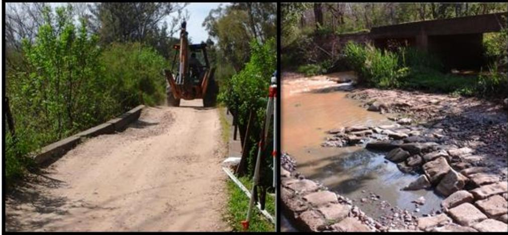
*Figura 6 - Imagen Relevamiento, máquina circulando por el puente Izquierda y estado del badén de piedra a la derecha.*
