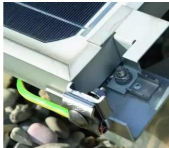
Ilustración 62 – Conexión de conductor de protección a estructuras
