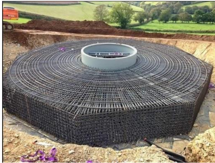
Ilustración 11 - Armadura de la base
