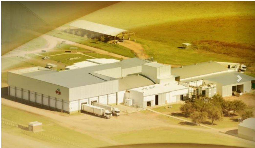
Ilustración 4 - Planta Frigorífica FADEL S.A.
