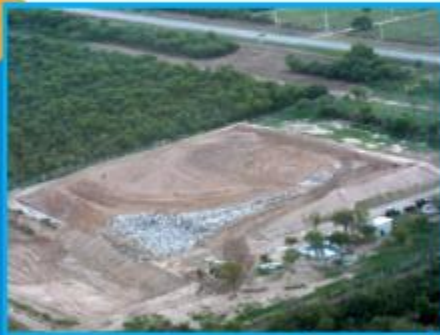
Frente de Trabajo de la fosa en operación
