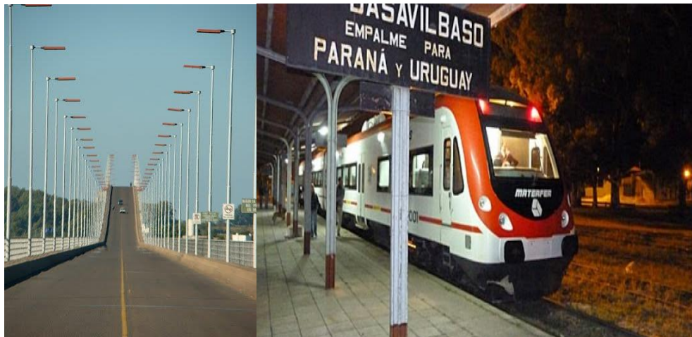
Figura 2-4, Izq.: Puente internacional General Artigas, Der.: Estación Basavilbaso Fuente: www.lacalle.com.ar , www.enelsubte.com
