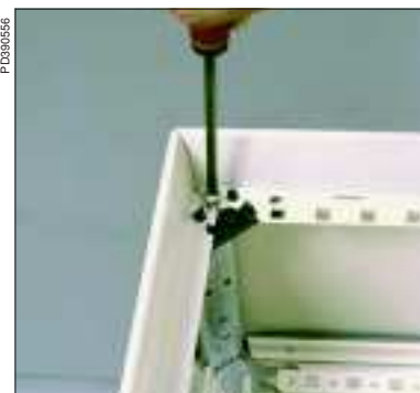
4 tornillos para fijar las paredes laterales de revestimiento.
