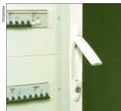
Las puertas equipadas con manetas ergonómicas y cerraduras de llave Ronis n.º 405 admiten otras cerraduras o cierres.
