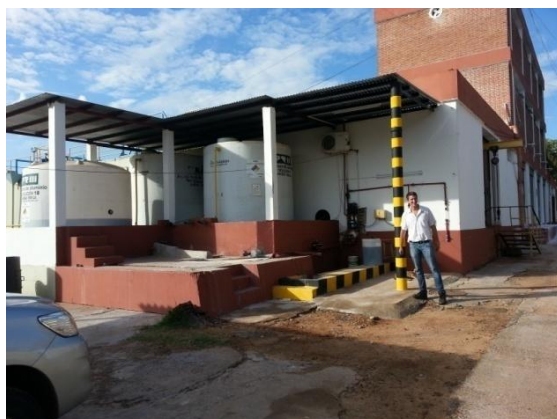
Tanques de almacenamiento y dosificación de PAC
