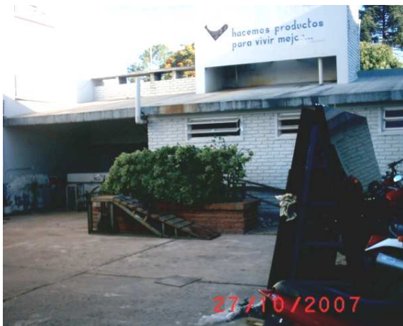
Sector de parrilla, vestuarios y sanitarios de aire
