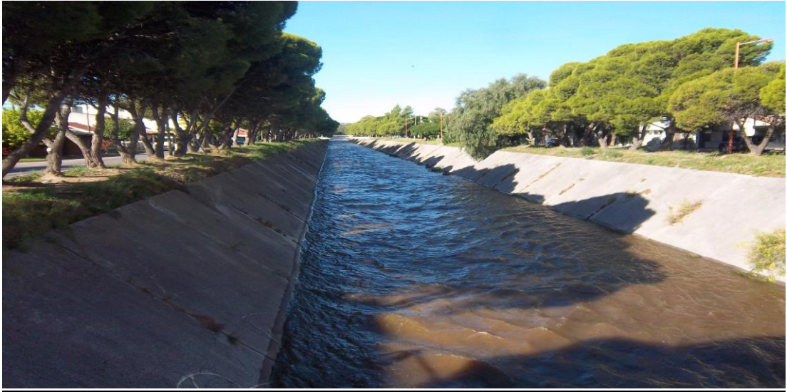
Foto N° 2 Vista del canal artificial Maldonado posterior a una precipitación.
