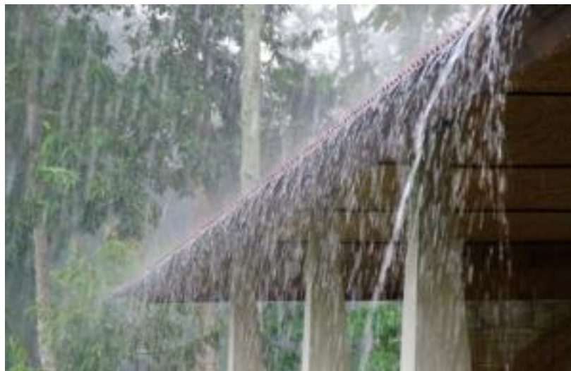
Foto N° 1 Típica escorrentía de techo
