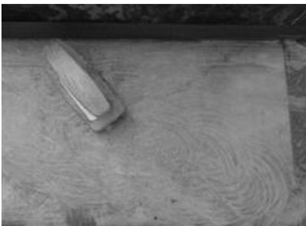
Figura 38: Aplicación de tensoactivo.
