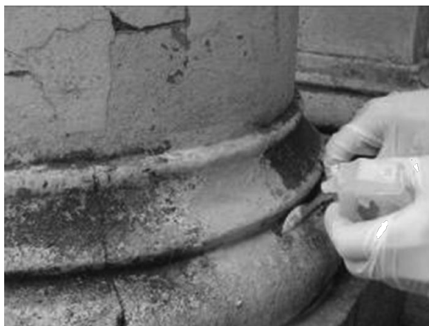
Figuras 43 y 44: Limpieza mecánica en superficie húmeda y enjuague.
