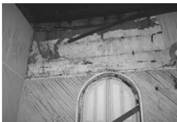
Figura 48: Esquina colapsada.
