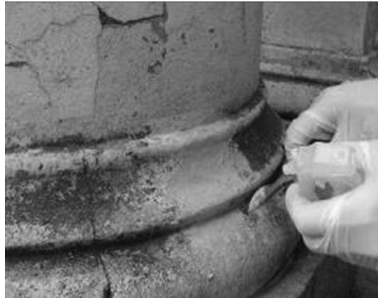
Figura 41: Limpieza mecánica.
