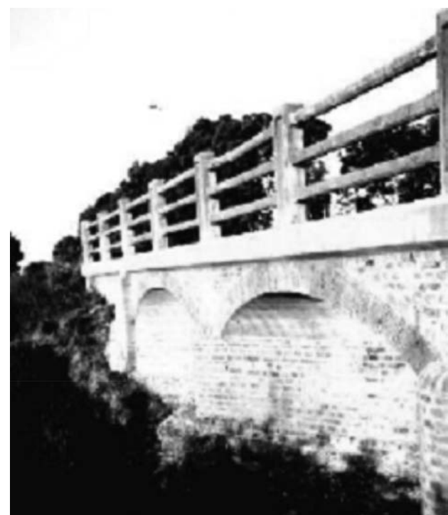
Figura 6: Puente sobre Ruta 205. Partido de Lobos.
