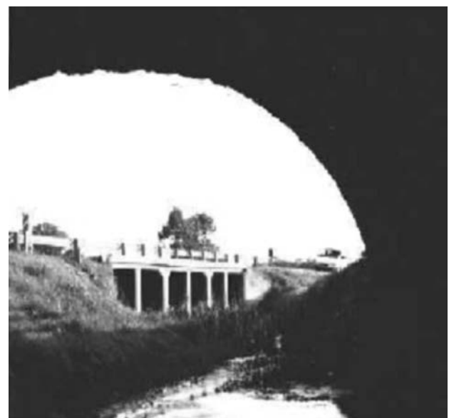
Figura 5: Puente sobre Ruta 205. Partido de Lobos.
