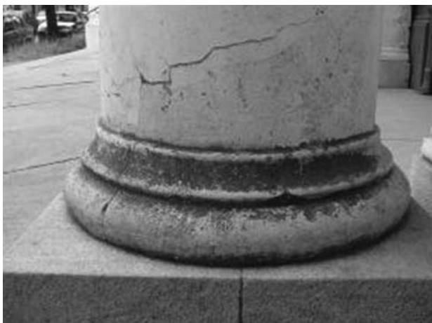
Figura 40: Base de la columna.
