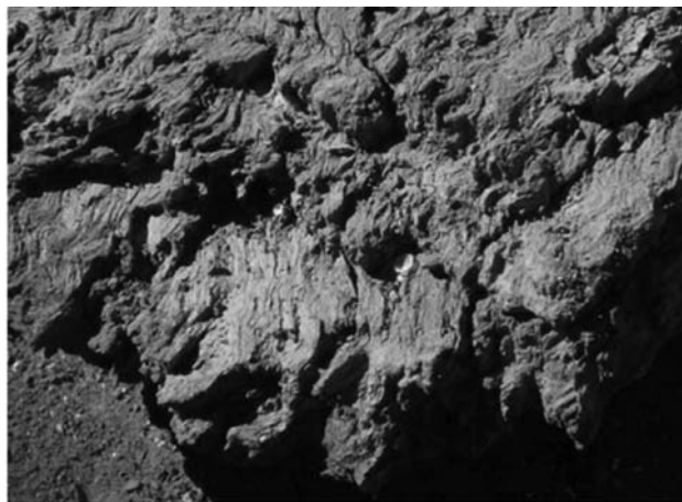
Figura 9: Madera afectada por pudrición parda.
