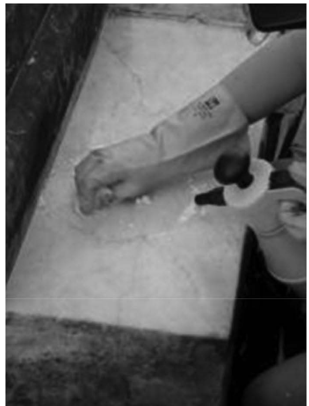
Figura 45: Bruñido con abrasivos a muñeca.
