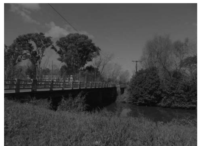
Figura 3: Puente sobre el canal del Arroyo Rodríguez
