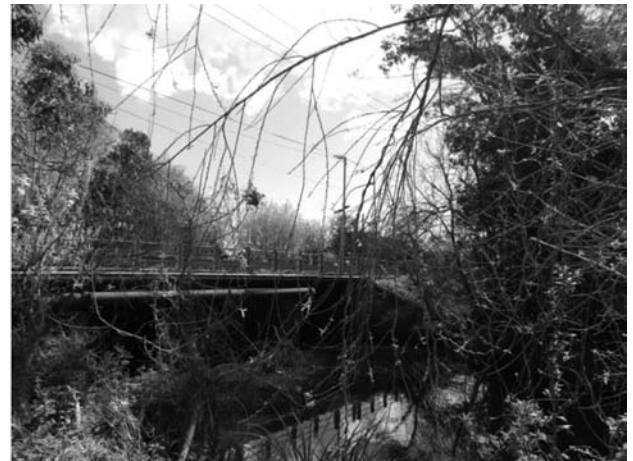
Figura 1: Puente sobre el arroyo Doña Flora.
