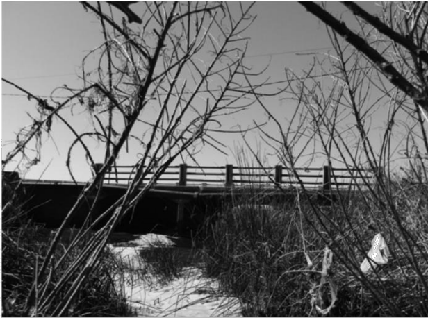
Figura 4: Puente sobre el Arroyo Miguelín
