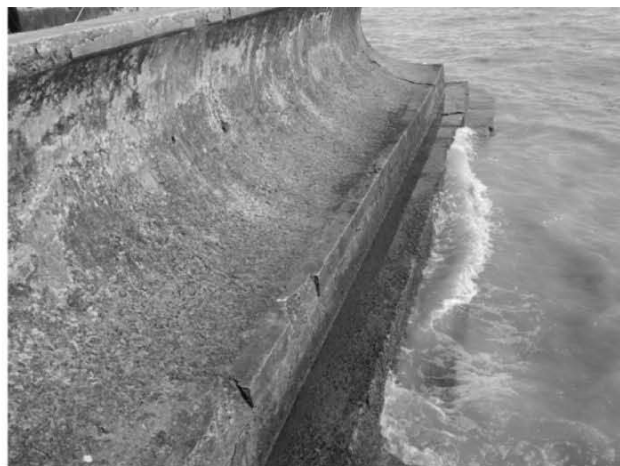
Figura 7: Muralla de defensa sobre la Av. Costanera.
