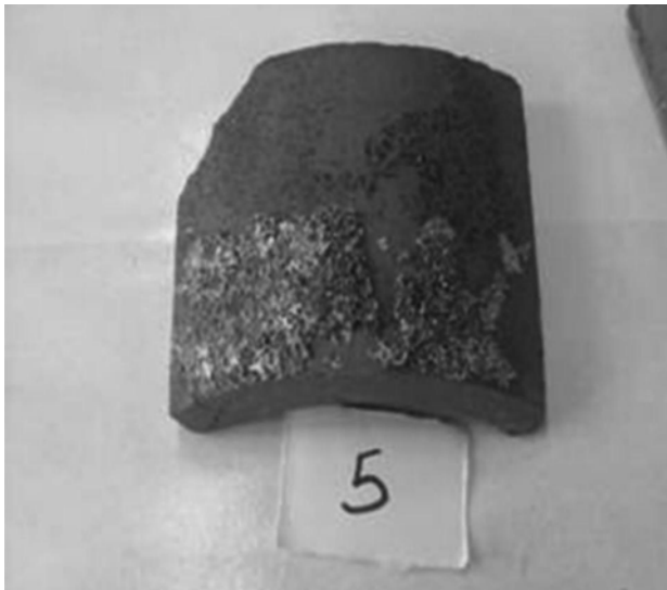
Figura 21: Teja de 60 años luego del crioreinado a 2.5 bar. Se observa la pérdida de material superficial.
