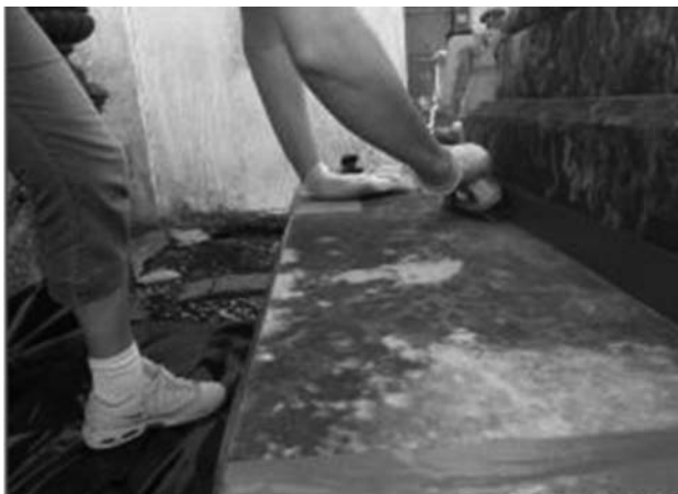
Figura 37: Cepillado a seco de la superficie.
