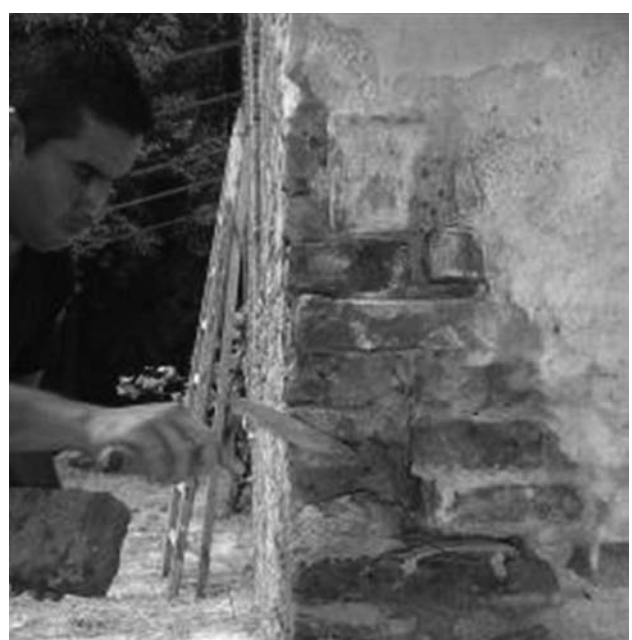
Figura 31: Reposición de ladrillos.
