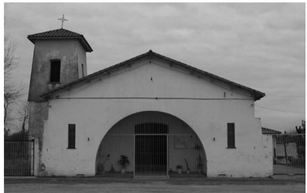
Figura 5: Vista de la Iglesia San José Obrero.
