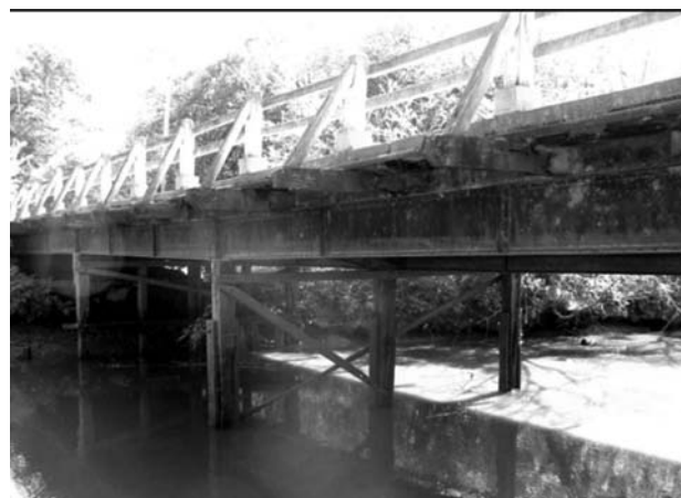
Figura 3: Vista del puente
