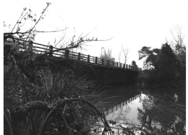
Figura 2: Puente sobre el canal del arroyo El Gato.
