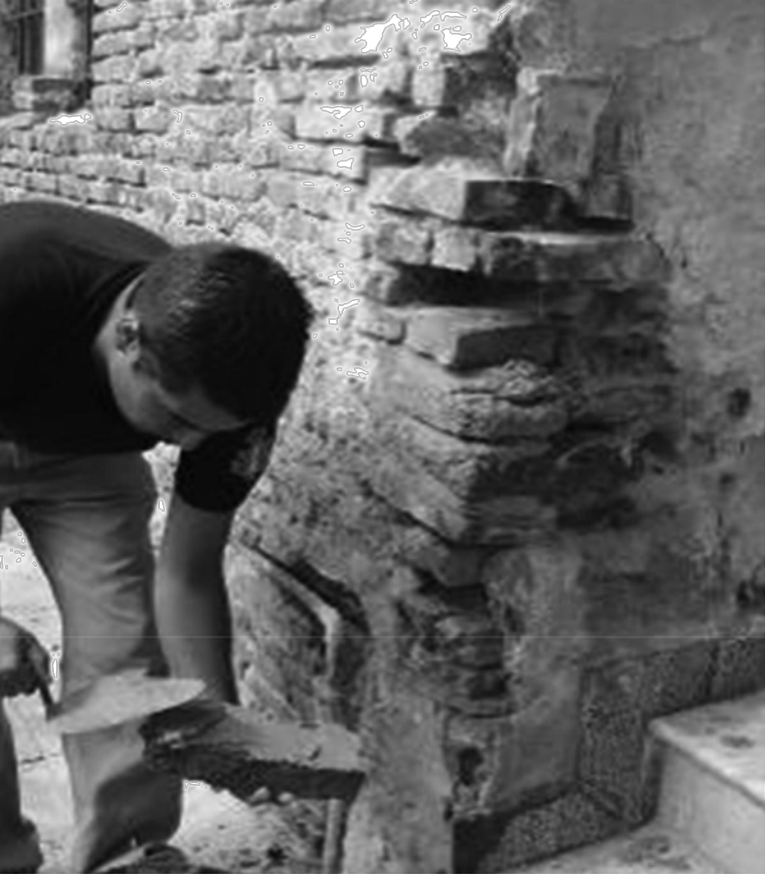
Figura 32: Reposición de ladrillos.
