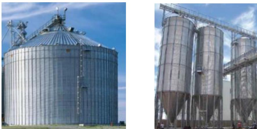
Imagen ID-14: Silos metálicos de capa acanalada
