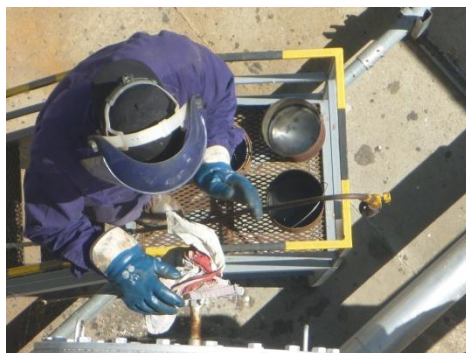
Figura 6. Tomado de la muestra de asfalto modificado
