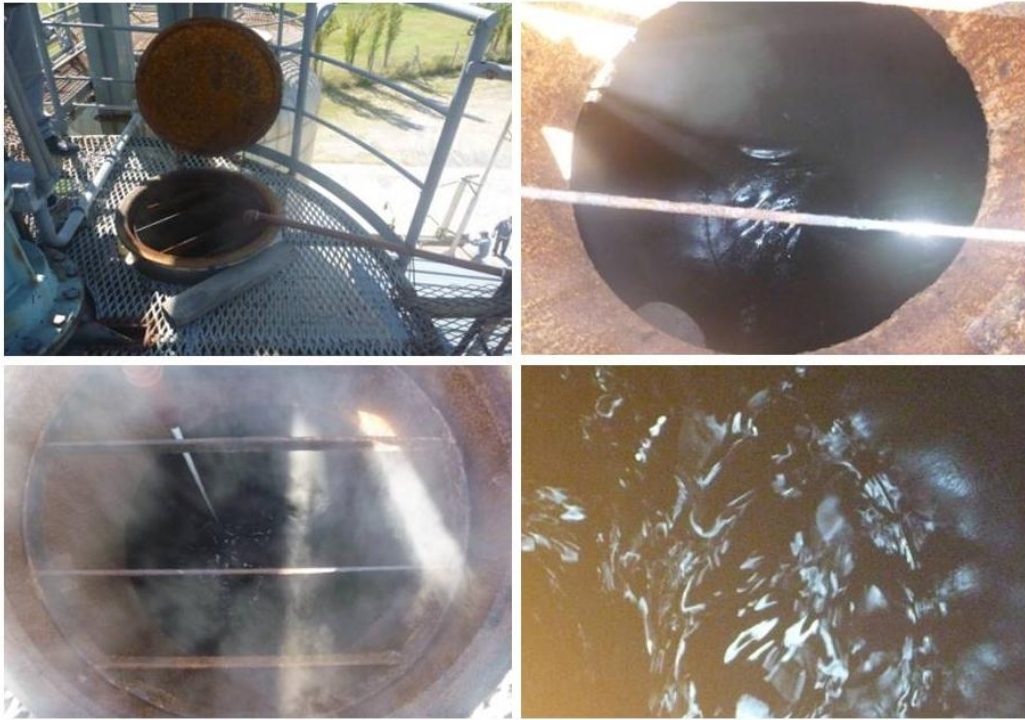
Figura 4. Vista de la compuerta, del cemento asfáltico y de la incorporación del polímero
