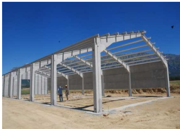
Figura 11.3. Estructuras metálicas con acero para techo.
