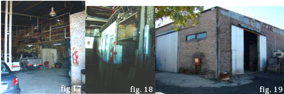
Fig.17 y Fig.18 – Demarcaciones y Luces de Emergencia + Matafuegos en sus lugares.
