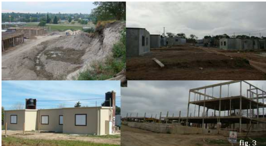
Fig.3 – Algunas Obras construidas por la empresa Viano Construcciones SRL.
