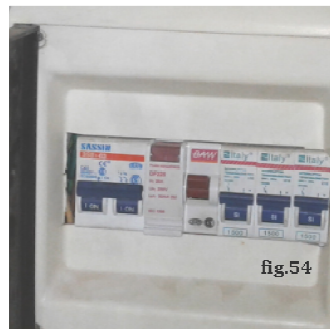
Fig.54 – Tablero Seccional con Doble puerta. Con DD e IT – Sector de Oficinas de Compras.
