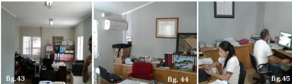
Fig.43, 44 y 45 – Condiciones de las instalaciones eléctricas del sector de oficinas.
