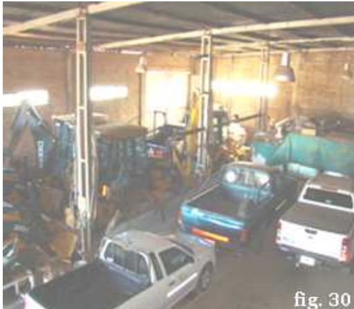
Fig.30 – Instalación de Iluminación en depósito cerrado respectiva medición Realizada 310J/K
