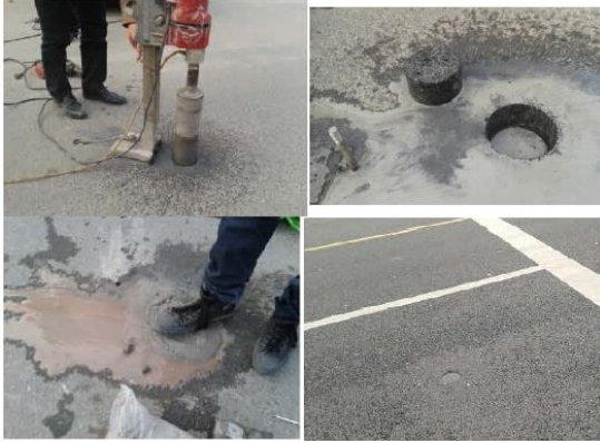
Fig. 7: Instalación de un sensor magnético en el asfalto.
