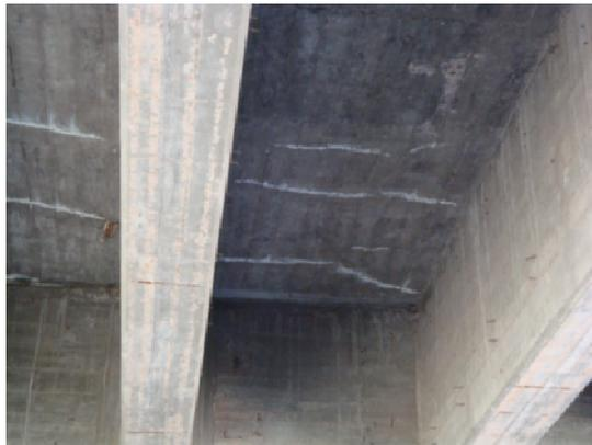
Las múltiples fisuras observadas, algunas de ellas con espesores mayores a 3 mm en la cara superior del tablero, favorecen los procesos de lixiviación, visibles en la cara inferior. Donde se observó el mapeo y midieron espesores de 0,1 mm en promedio.
