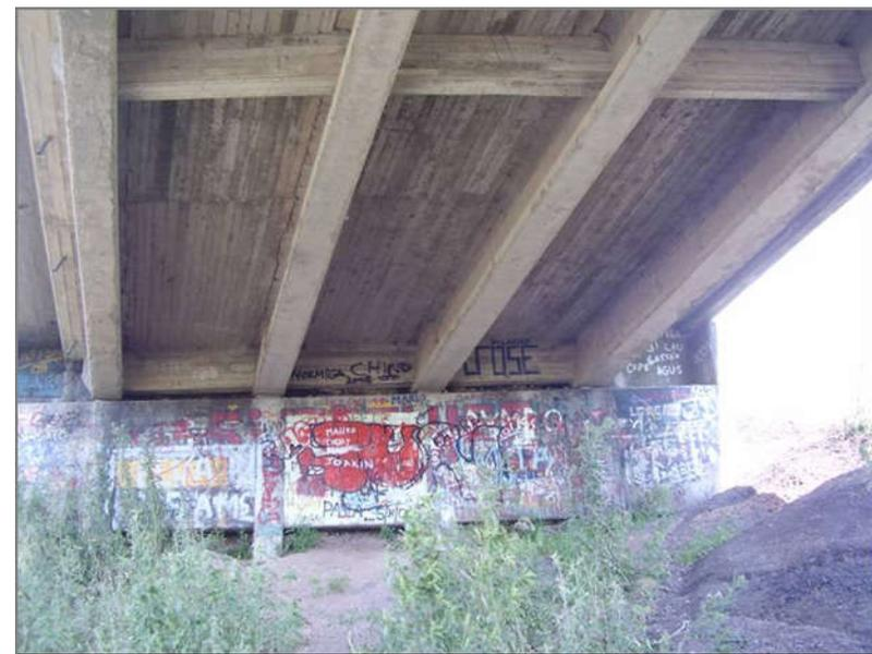
**Detalle de desagüe y vista inferior de estribo este.**
