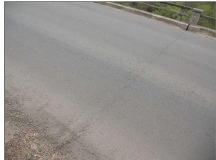
Vista del tablero del puente, luego de la re-pavimentación. Juntas de dilatación entre tablero y losa de aproximación.
