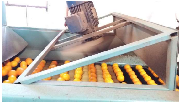
Imagen N°34: Foto de ventilador sin protección en empaque de la Citrícola Santa Carmen
