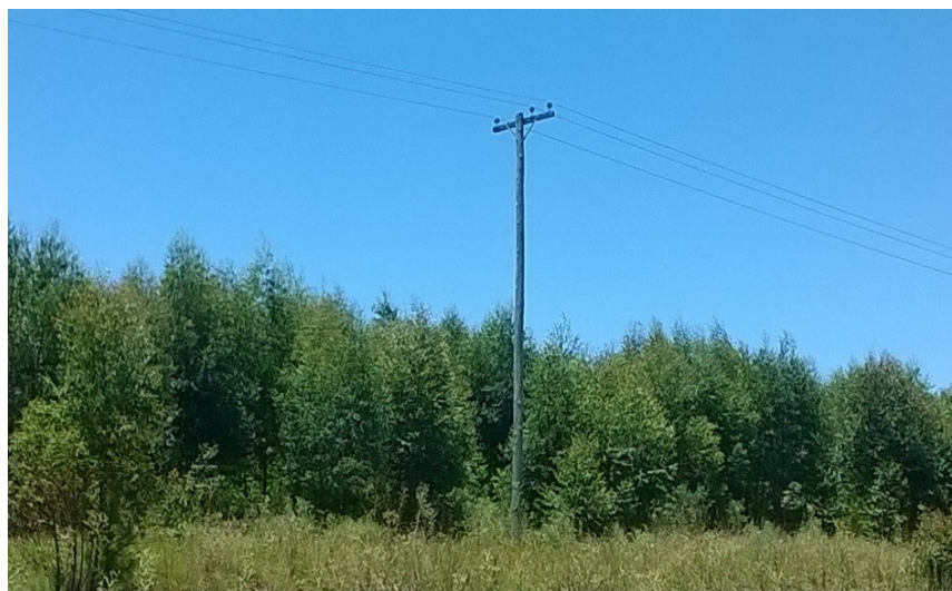
Cabezal y estructuras redes actuales.
