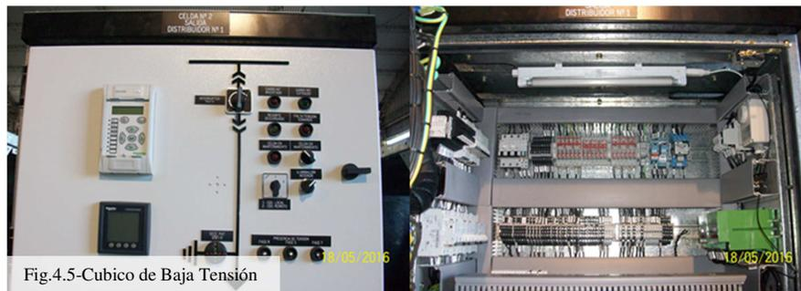
Fig.4.5-Cubico de Baja Tensión
