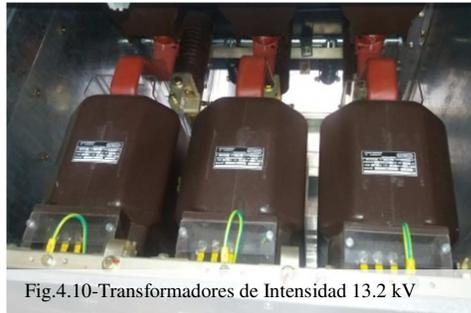
Fig.4.10-Transformadores de Intensidad 13.2 kV
