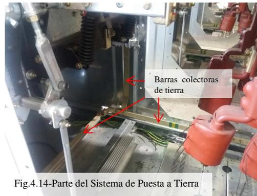
Fig.4.14-Parte del Sistema de Puesta a Tierra
