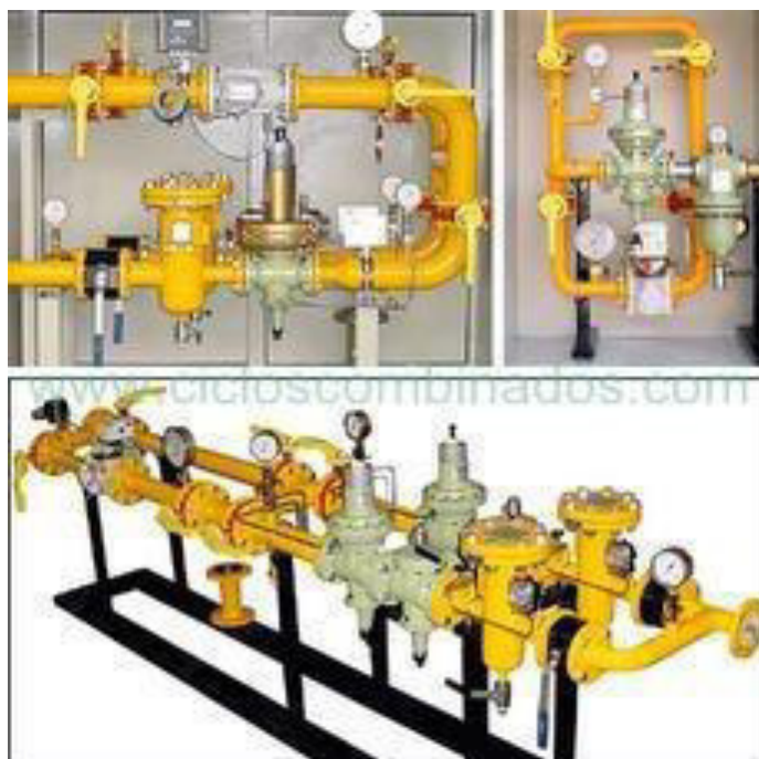
Figura 8.9 | Partes componentes de una E.R.M.-
