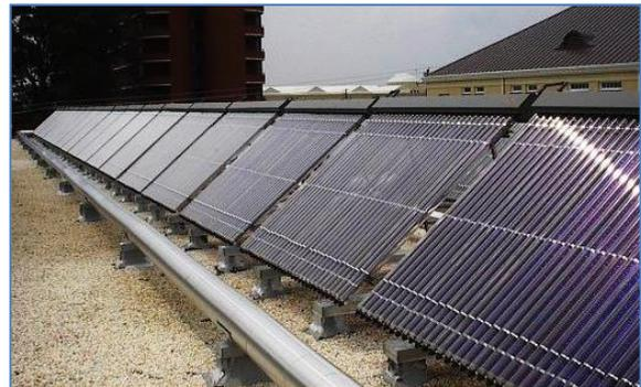
Los colectores solares son de la empresa Thermomax y se selecciona el modelo que se describe más adelante ya que según los manuales técnicos de la compañía es el recomendado para las aplicaciones de refrigeración y climatización. En las especificaciones técnicas “ET2 - ASTRON TMO600” se pueden ver mayores datos de los mismos.
