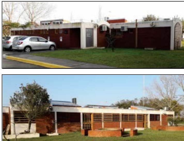
Figura 11: fotos del exterior del edificio.
