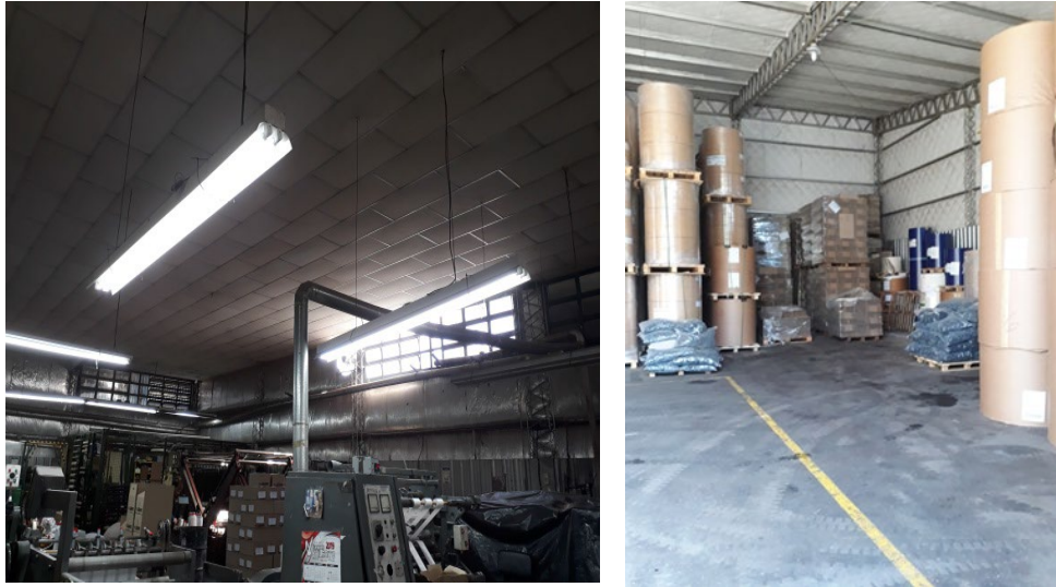
Imagen 7: Techo y cubiertas.
