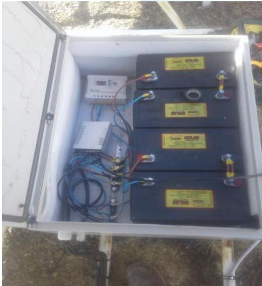
Electrónica con energía solar fosfolítica 24volt.
