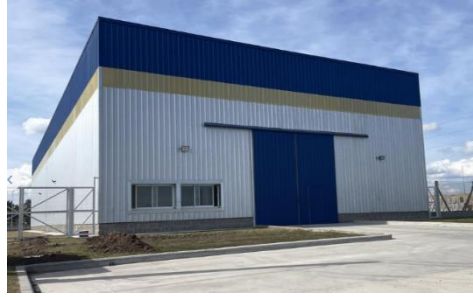
Figura 10. 3 Depósito de almacenamiento
