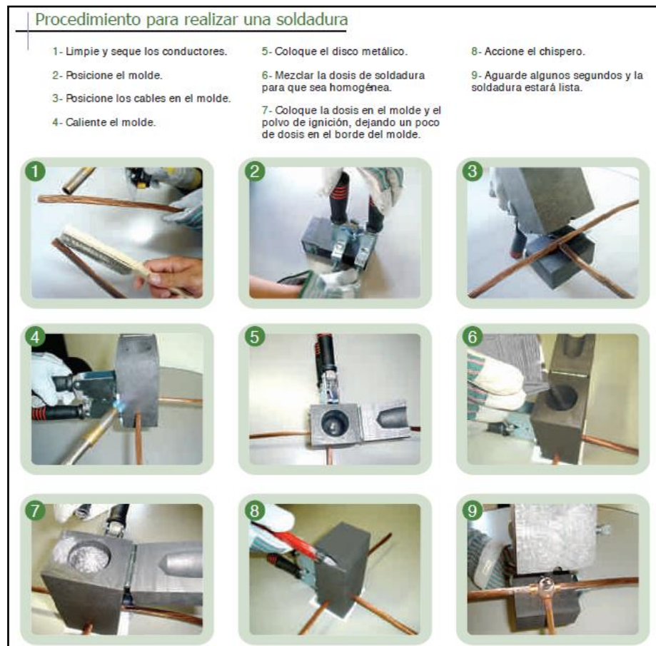
Figura ID-98: Genrod, 2024, Procedimiento de soldadura, imagen, Catálogo de PAT.
