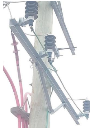
Figura 14: Montaje de Descargadores en Cabezal de Subestación
