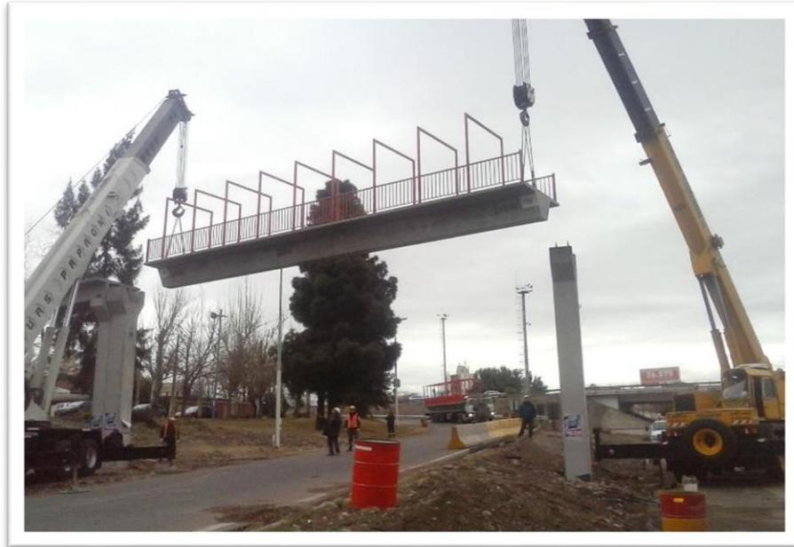
*Figura 37: Foto izaje de pasarela premoldeada por Prear*
