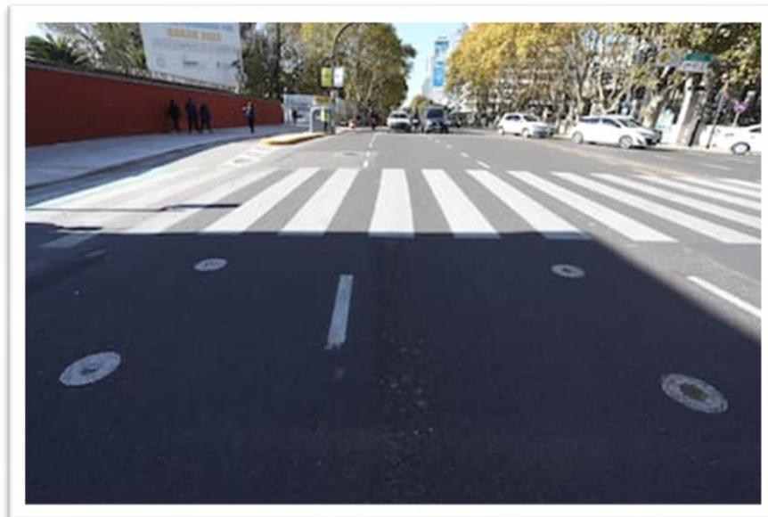
*Figura 18: Los círculos blancos rodean los sensores colocados bajo el asfalto de la Avenida del Libertador.*
