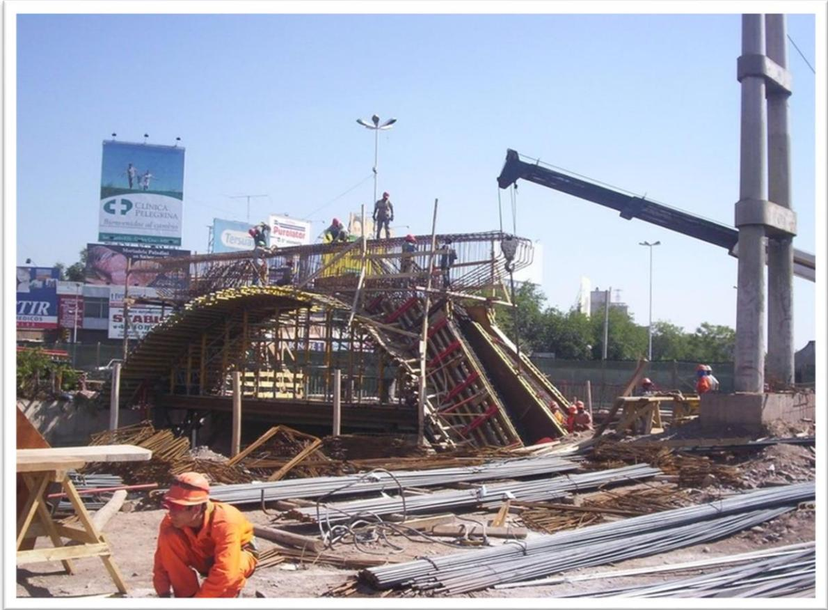
*Figura 9: Construcción de pórtico del viaducto*
