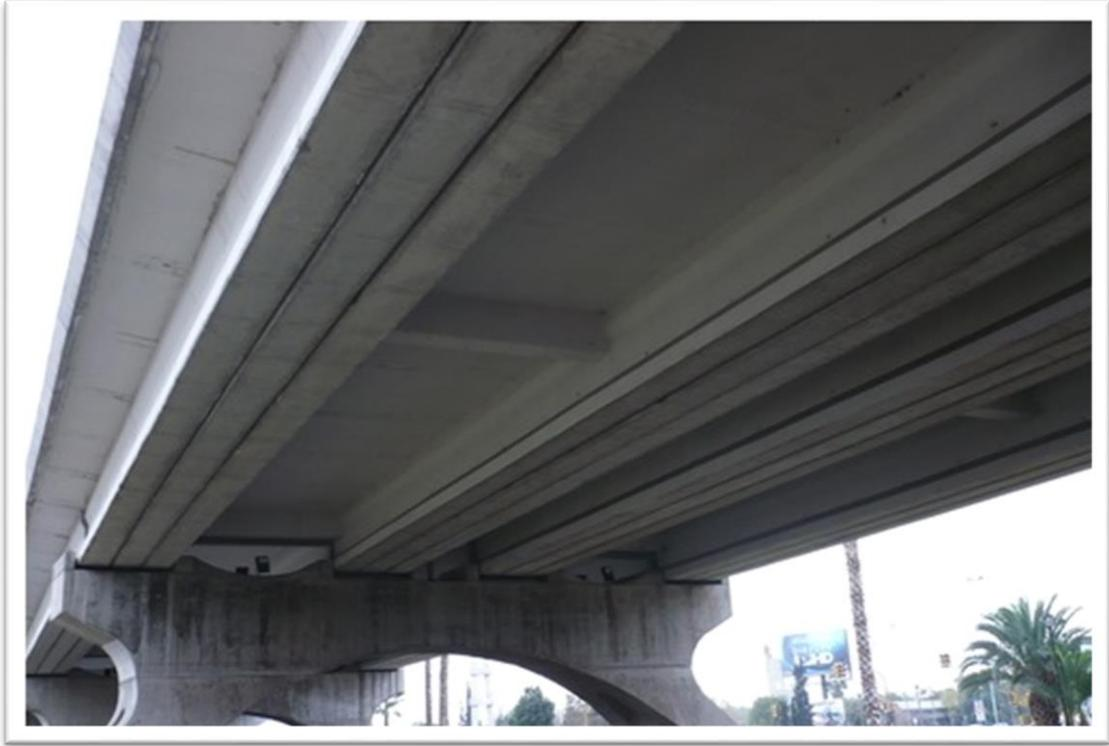
*Figura 12: Vigas y losas montadas*
