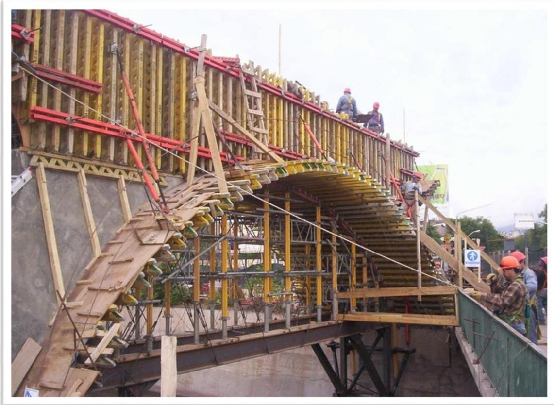
*Figura 10: Construcción de pórtico del viaducto*
