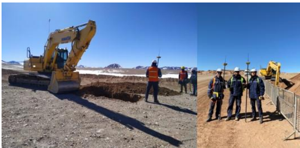
FIGURA 4: Trabajos en ingeniería Civil.
