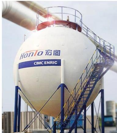
Figura 10.31. Tanque de almacenamiento de propano.
