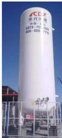
Figura 10.33. Tanque criogénico presurizado de acero al carbono para almacenamiento de nitrógeno líquido.
