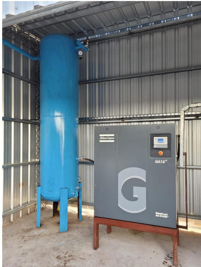
*Figura 23: Compresor y tanque pulmón.*
