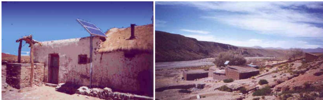
Figura N° 23: fotografías de Instalaciones fotovoltaicas aisladas en noroeste argentino
