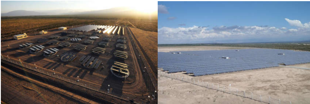
Figura N° 22: Planta FV piloto de Ullúm (izquierda) y parque solar FV en de Cañada Honda – San Juan (derecha)
