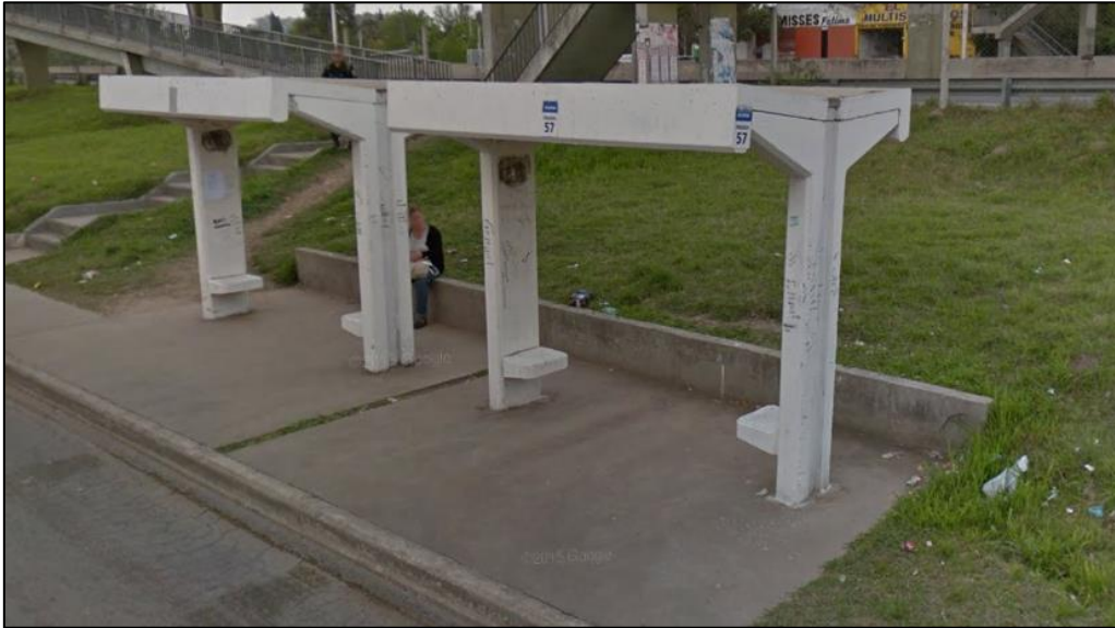
Imagen 2.4.2 b - Refugio de pasajeros (1) sobre colectora este, mano a Pilar – Fuente: Google Earth
