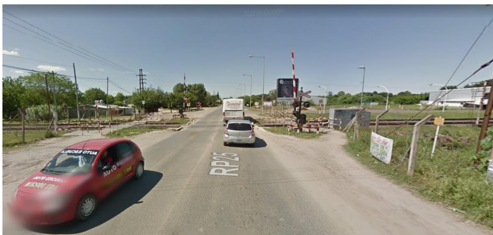
Vista Panorámica de Cruce a nivel de Ruta 25 con FFCC Belgrano Norte - Fuente: Google Maps
