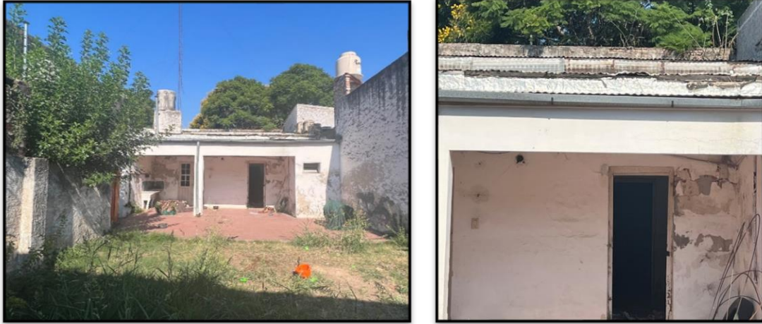
Figura N° 6 – Contrafachada y cubierta
