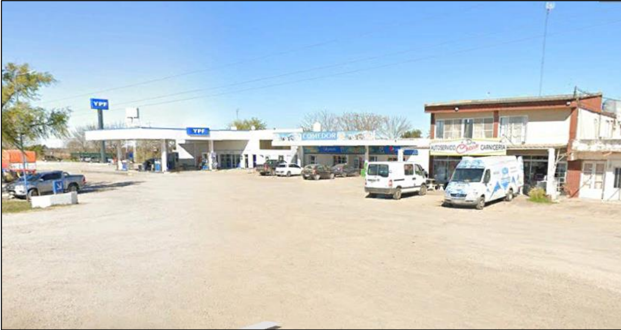
Figura 1.3 – Estación de servicio y comedores ubicados en la zona de proyecto
