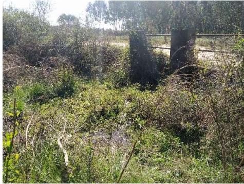
Imagen 1.3-1 Estado de alcantarilla.
