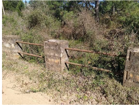
Imagen 1.3-2 Estado de alcantarilla.
