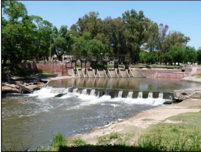
*Imagen 11: Vista desde aguas abajo de las compuertas de control de nivel sobre el brazo izquierdo, después de la bifurcación del cauce–
