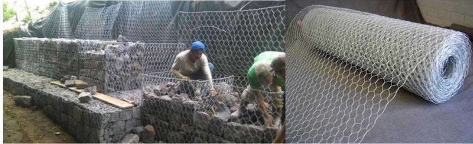
Imagen 12: Muro de contención con gaviones y malla eslabonada de triple torsión
