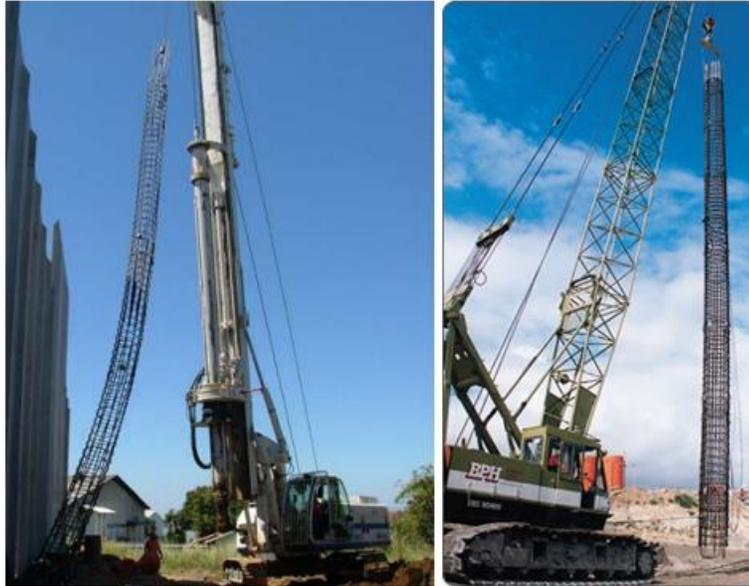
*Imagen 21. Izado de armadura previamente confeccionada*
