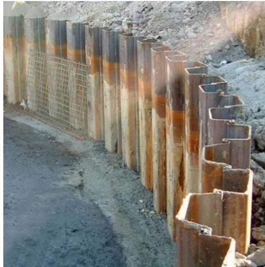
*Imagen 15. Concepto de muro de contención con tablestacas de acero*
