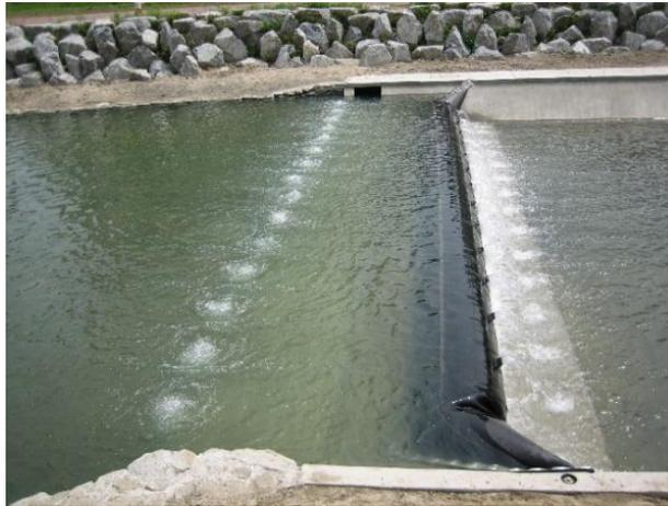
*Imagen 41. Ejemplo de funcionamiento de una compuerta de goma inflable*
