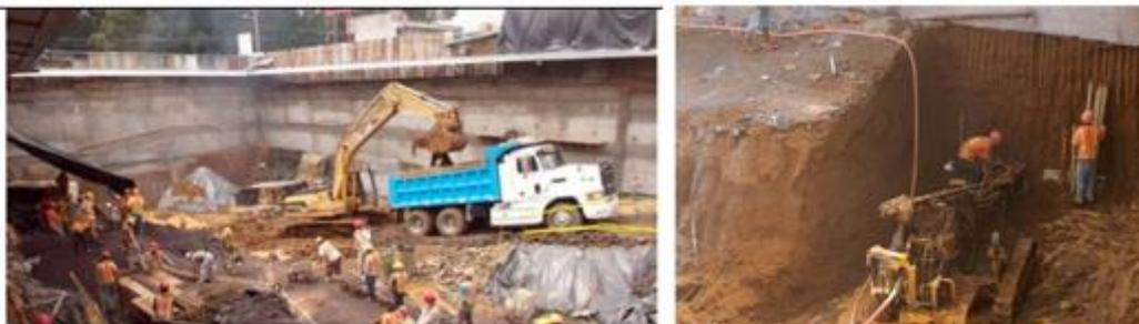
*Imagen 22. Anclajes para estabilidad del muro*
