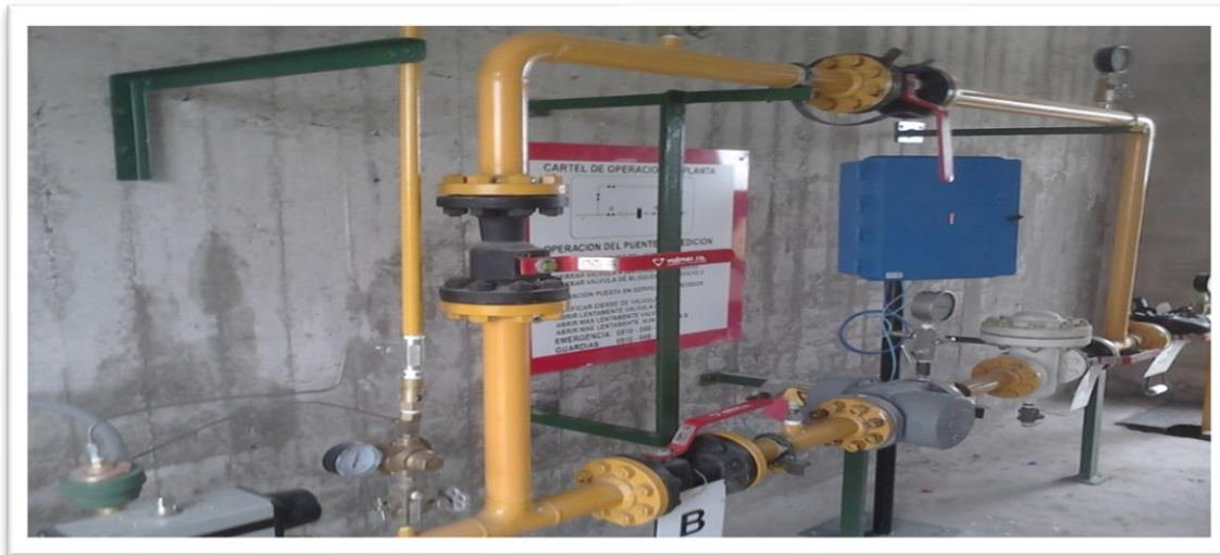
Imagen 6. Puente de medición
