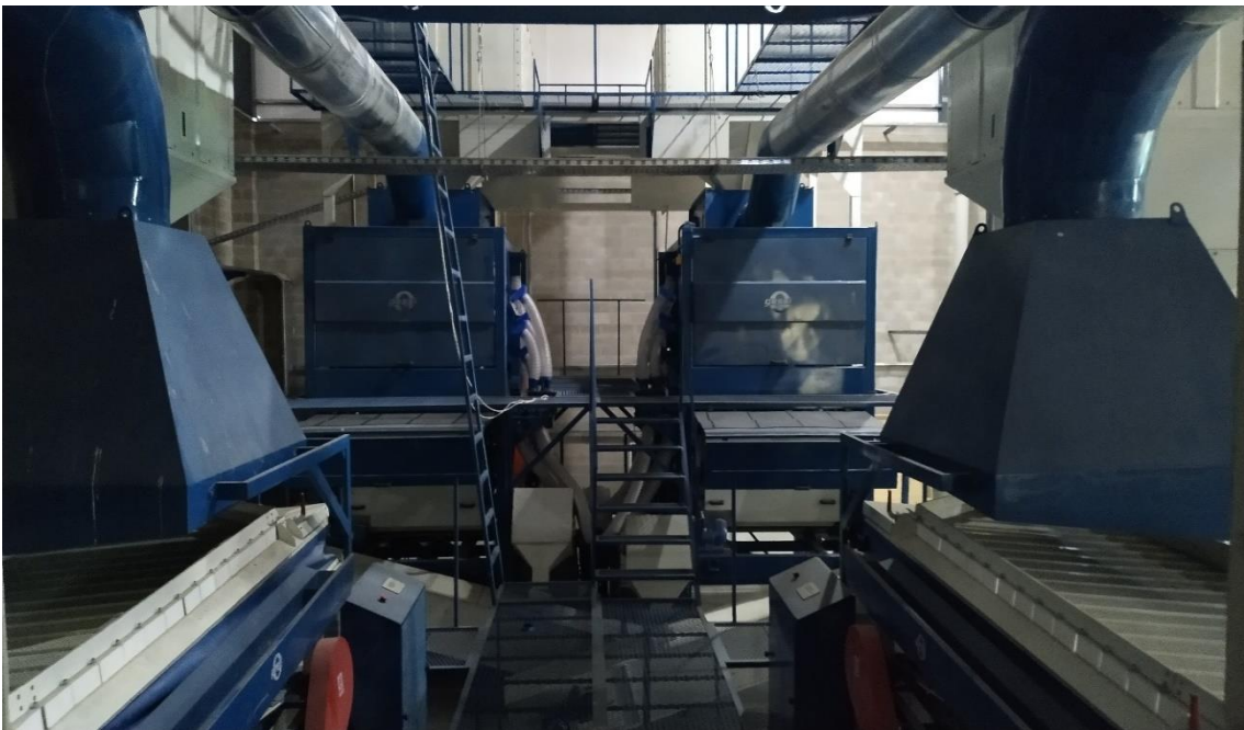
fig. n° 58: pasarela de operación sector Densimétricas
