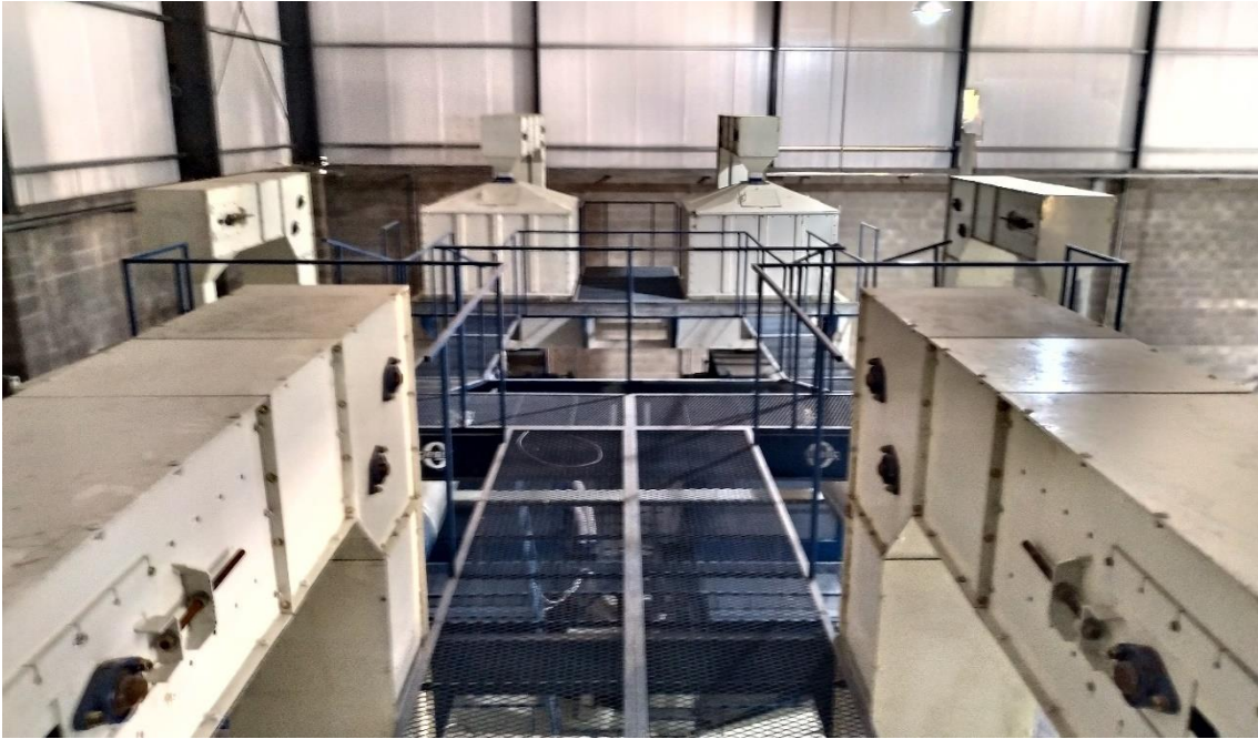
fig. n° 57: vista superior, pasarelas de supervisión de tolvas y elevadores.
