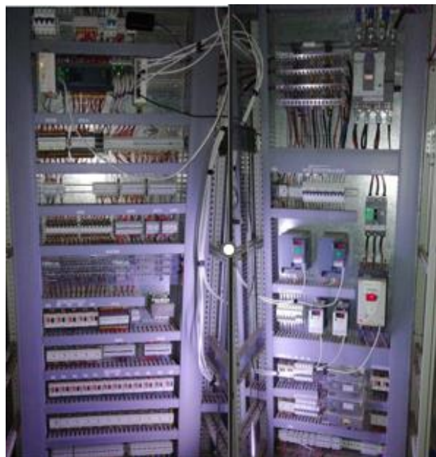
fig. n° 29: Montaje del tablero eléctrico
