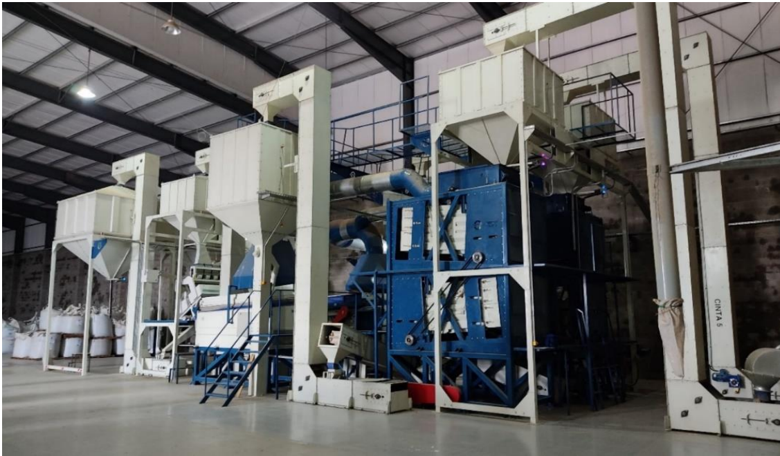
fig. n°55: Vista lateral de la planta procesadora
