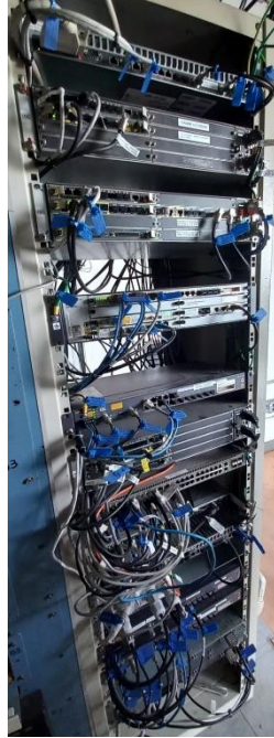
Figura N°. -21 Sitio Celular Claro – Placas de radiofrecuencia.
