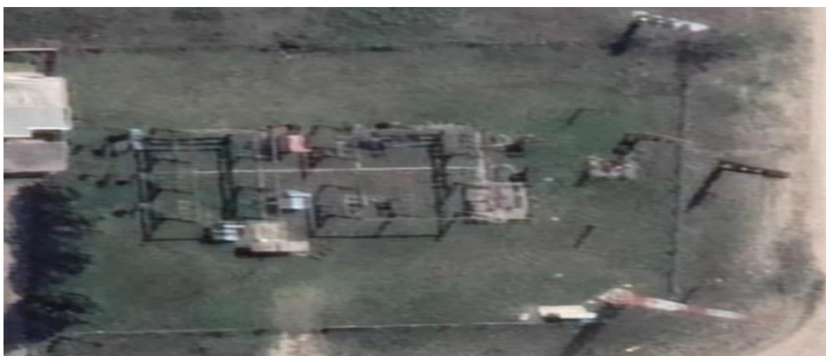
Figura 1: Vista aérea de la Subestación Transformadora de Viale (2)
