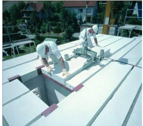
Figura 18. Placas de forjado
