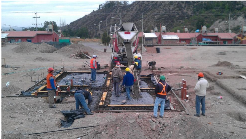
Figura 19. Llenado de platea de fundación
