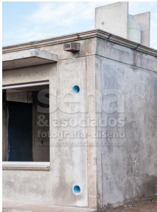
Figura 23. Desencofrado y terminación final
