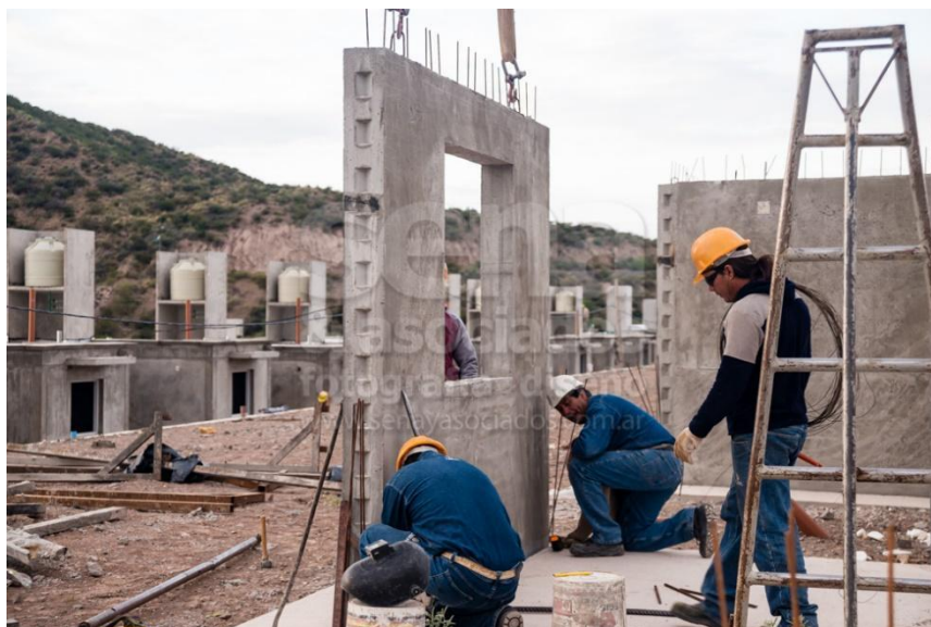
Figura 21. Colocación de paneles
