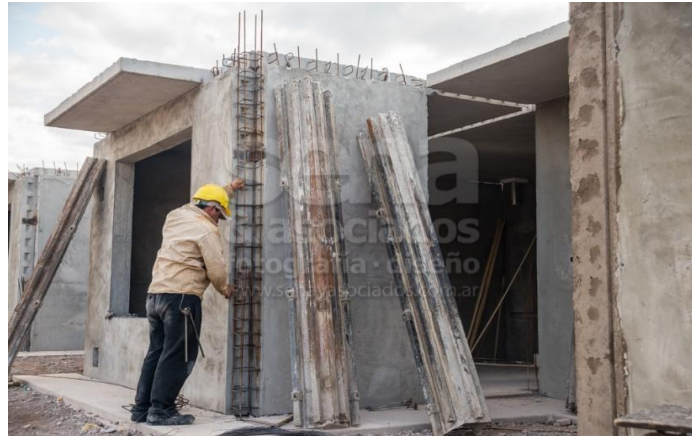
Figura 22. Armado y encofrado de vigas y columnas
