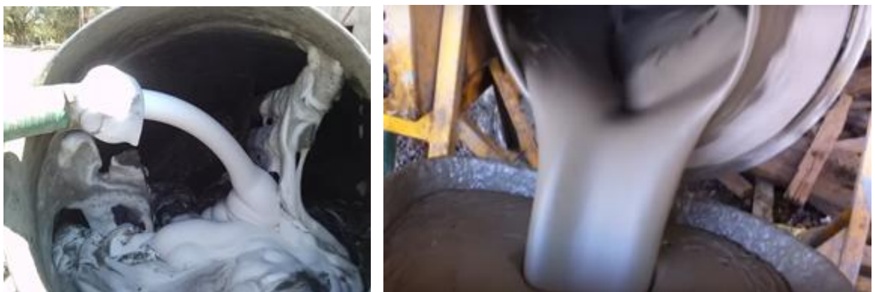
Figura 9. A la izquierda la colocación de espuma durante el amasado y la derecha la consistencia final del hormigón celular en estado fresco.
