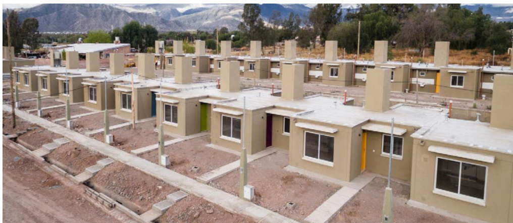
Figura 24. Vista panorámica del barrio
