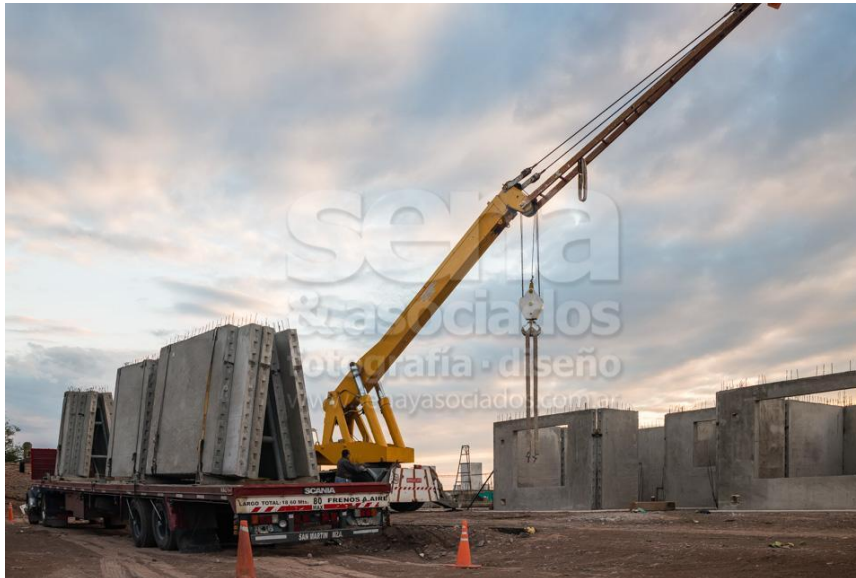
Figura 20. Transporte de paneles prefabricados y grúa de montaje
